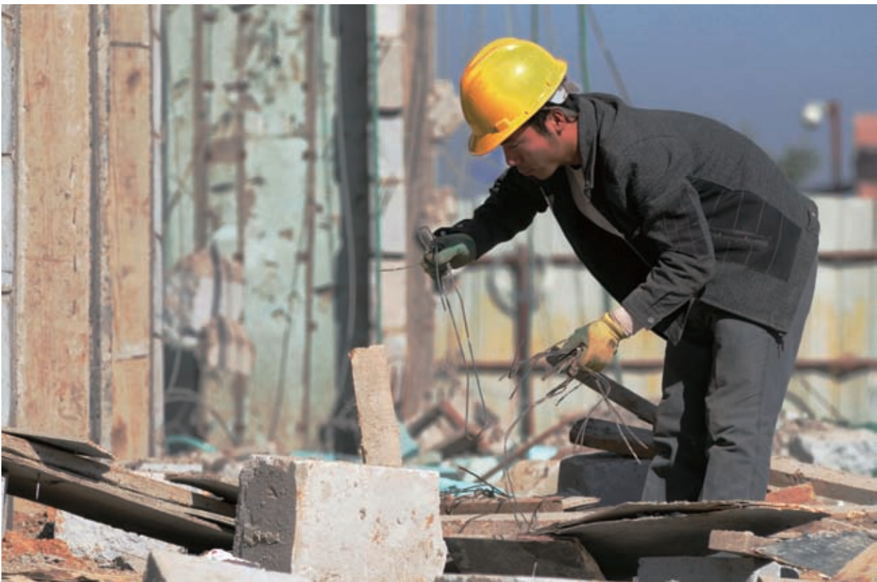
Ein chinesischer Arbeiter auf einer Baustelle
