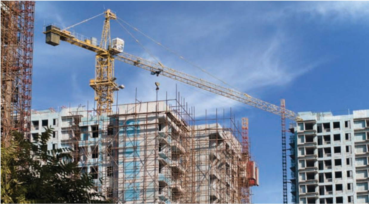
Bauarbeiten an einer Wohnanlage in Peking
