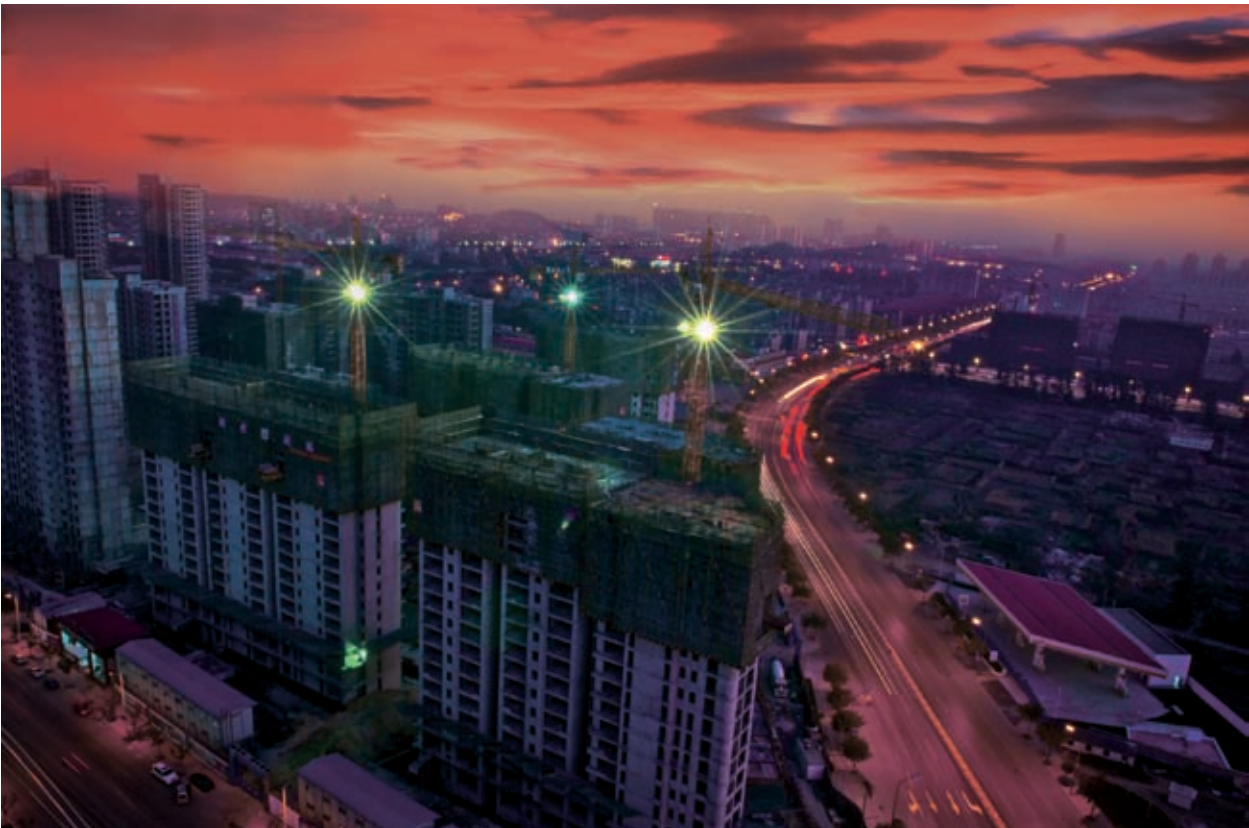
Eine Baustelle in Tangshan bei Nacht
