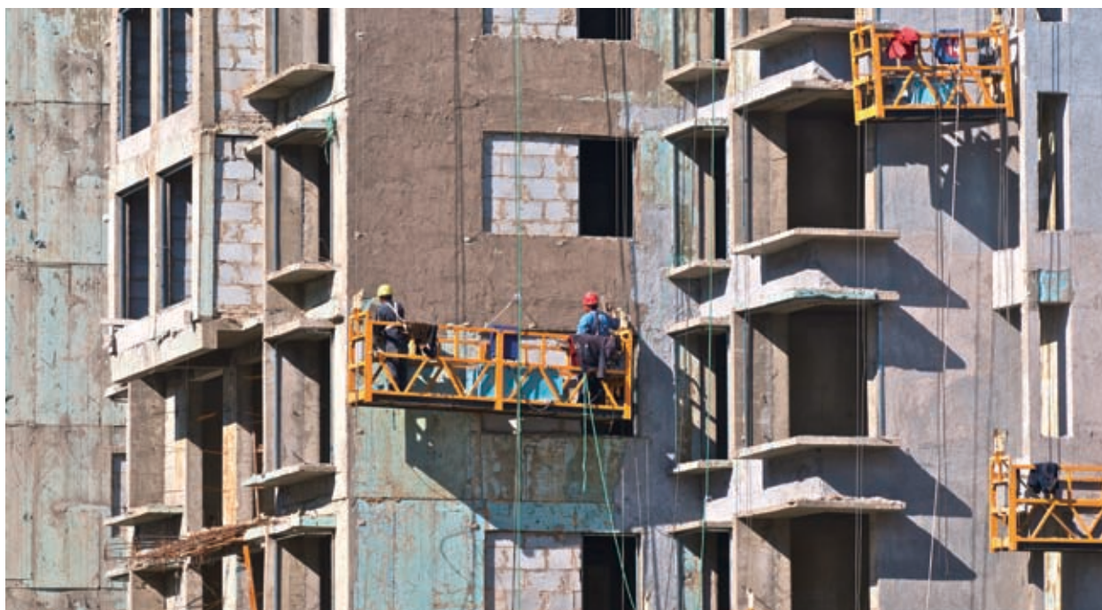
Fassadenarbeiten an einem Wohnblock
