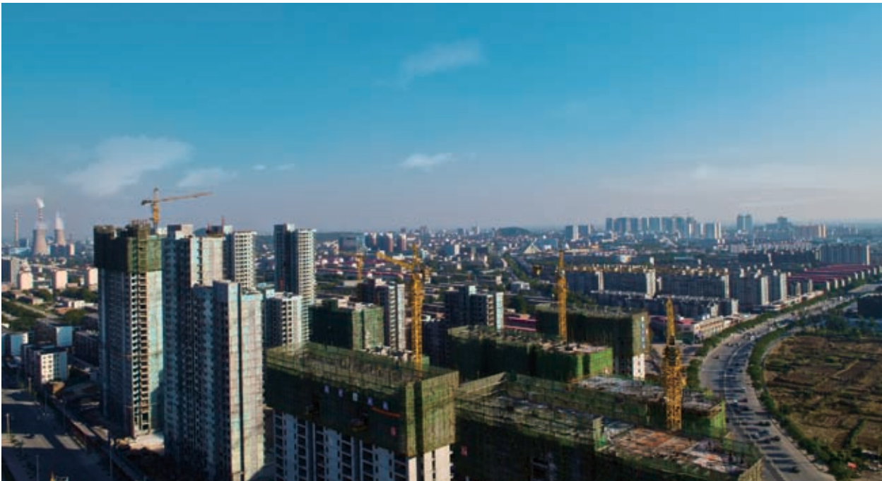
Ansicht einer Baustelle in Tangshan
