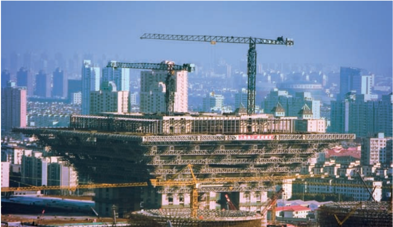
Der chinesische Expo-Pavillon während der Bauphase
