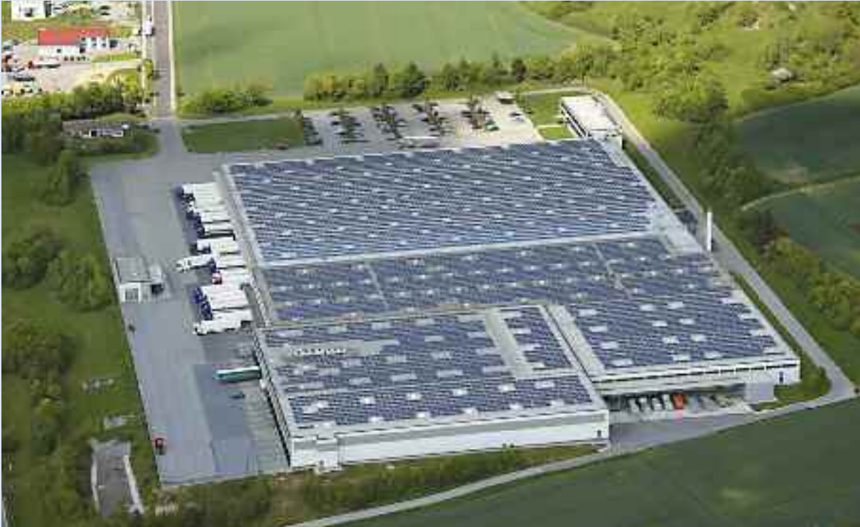
Die Photovoltaikanlage des DCM Solarfonds 1 auf dem Dach des ALDI-Logistikzentrums in Regenstauf (Bayern).
